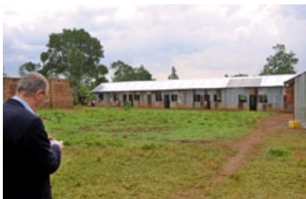
Die alte (2008) und die neue (2013) Schule
